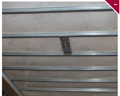
Nieprawidłowe zamocowanie lub brak elementów wyposażenia przestrzeni ładunkowej.
